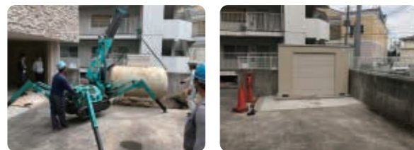
■カニクレーンを使用した施工現場
