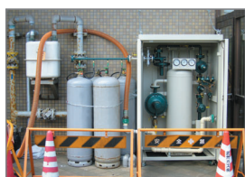
新潟中越沖地震 老人福祉施設
